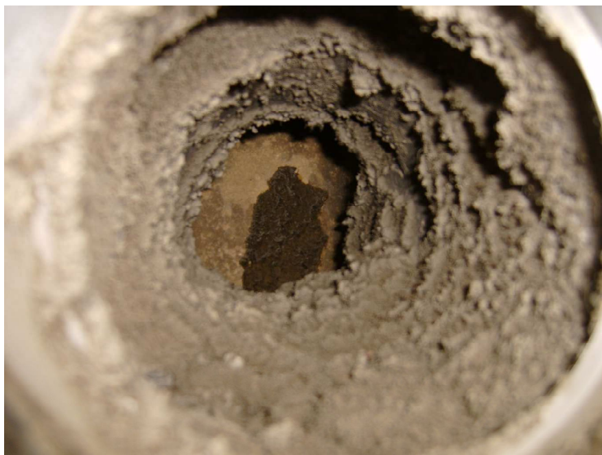
Stanje zaprljanosti dimovodnih cijevi
